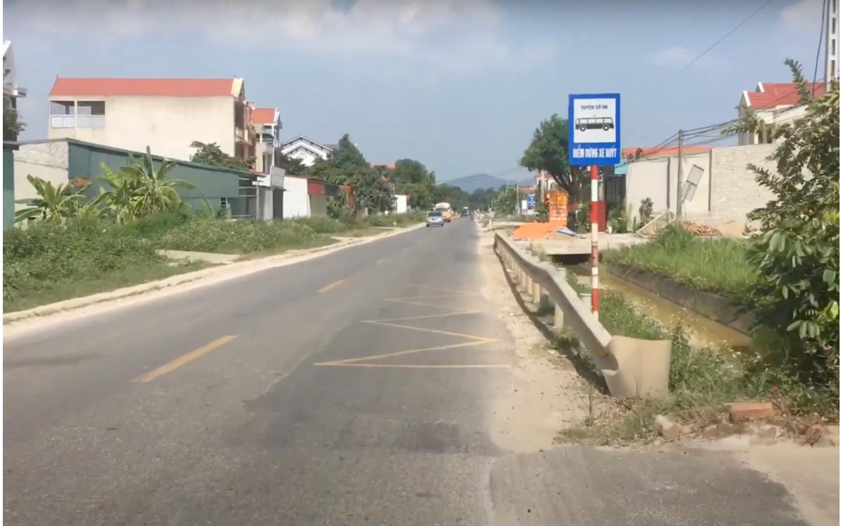
Hình 1. 3. Hiện trạng tuyến đường kết nối với dự án
